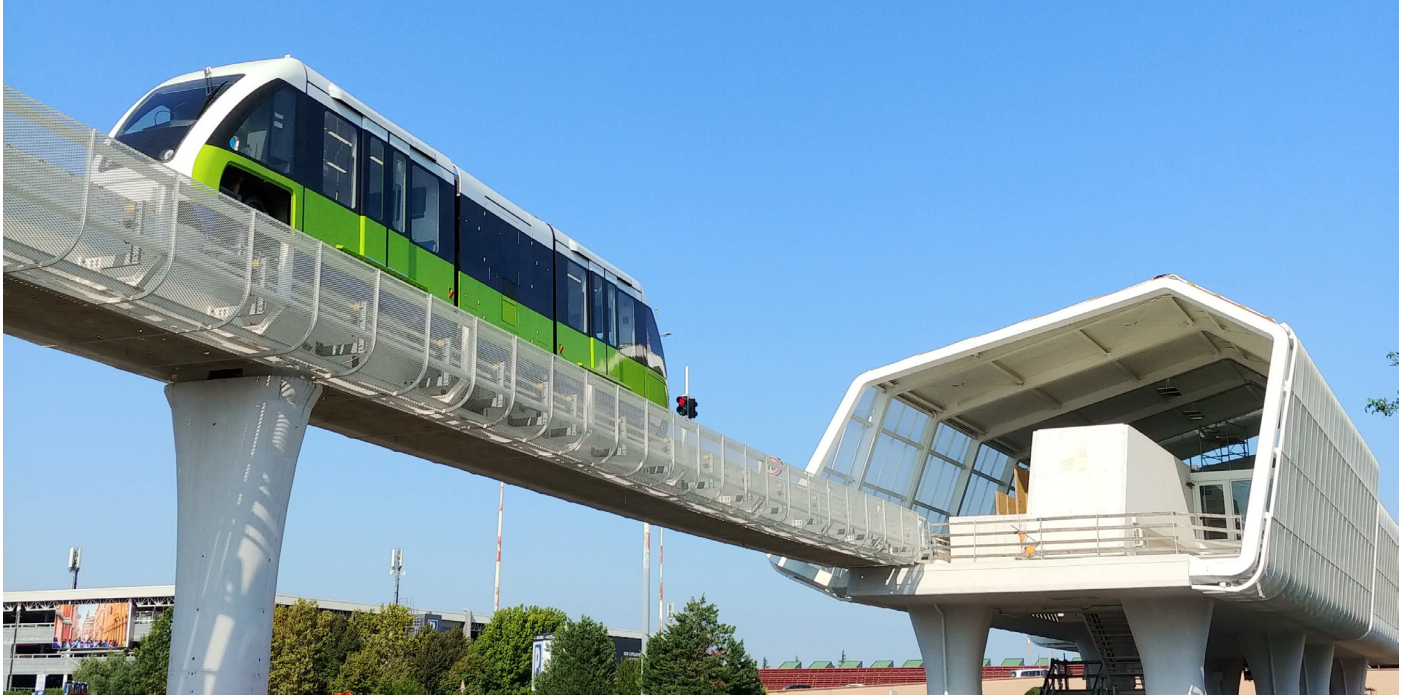
La monorotaia del Marconi Express, il veicolo che collega l'aeroporto alla stazione centrale
