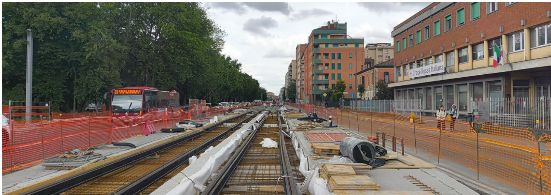
Un cantiere del tram quasi ultimato sulla via Emilia (Ansa)
